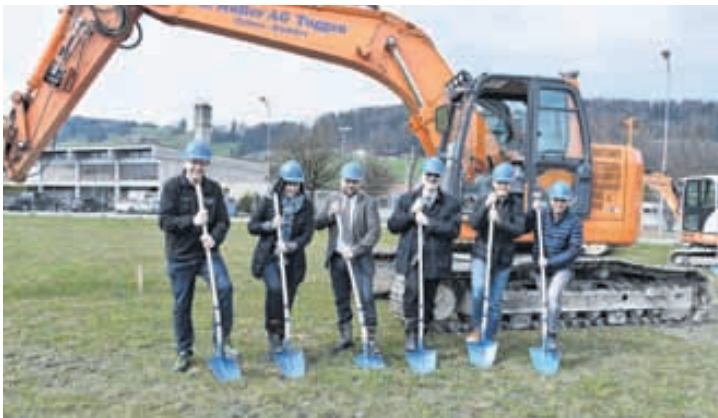
Am Spatenstich dabei: (v. l.) Fredy Bamert, Feuerwehr Tuggen; Ruth Schuler, Ressort Liegenschaften; René Knobel, Werke; Rolf Hinder, Gemeindepräsident; Daniel Hensel, Architekt; Edgar Morger, Bauleiter.
